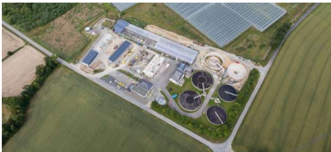
STATION D'ÉPURATION DES EAUX USÉES DE SAINT-ERBLON
