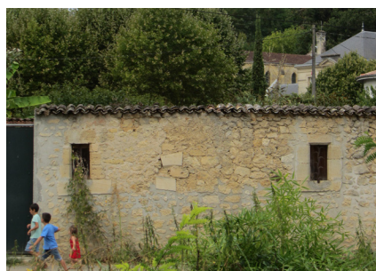
mur d'enceinte protégé de tuiles
