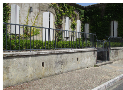
muret soubassement, grille + haie
