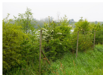
grillage souple et poteaux bois + haie champêtre
