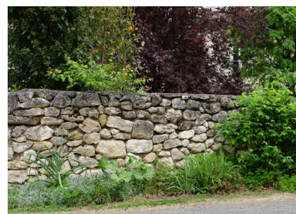
muret ancien en moellons
